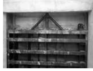
Devecikonağı HES Tekerlekli Kapak Ps = 16 m H = 5500 mm W = 4200 mm
