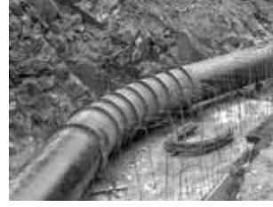
Vizara HES Cebri Boru Çelik, 4000 m, \phi = 1.4 m
