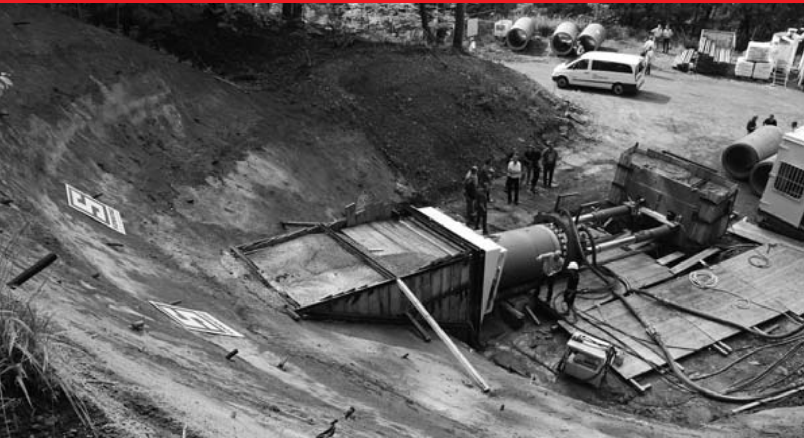
Oben: Blick in die Press-Station mit Widerlager aus überschrittenen Bohrspfählen. Unten: Zufriedenes Trio – Niederlassungsleiter Bingen Alfons Bongard, Projektleiter Christian Trittenbach und Bauleiter Florian Vogel.
