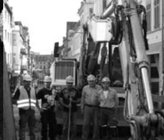
Arbeiten umsichtig in der engen Nerostraße: Polier Andreas Schneider und sein Team.
