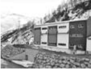
Vizara HES Santral Binası
