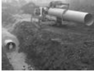
Akdere HES Cebri Boru, CTP - 4000 m
