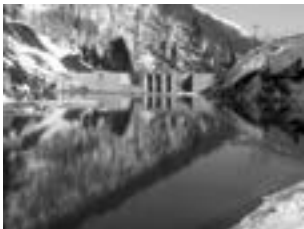
Vizara HES Beton Ağırlık Baraj H = 26 m
