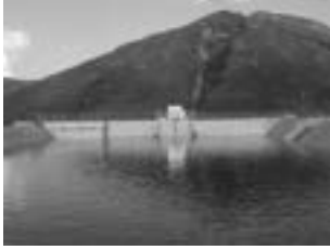
Kaletepe HES Yükleme Havuzu Günlük Regülasyon Deposu 35.000 m 3
