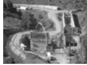
Köprübaşı HES Beton Ağırlık Baraj H = 23 m
