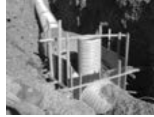
Kaletepe HES İletim Hattı U-PVC Boru, 11.500 m
