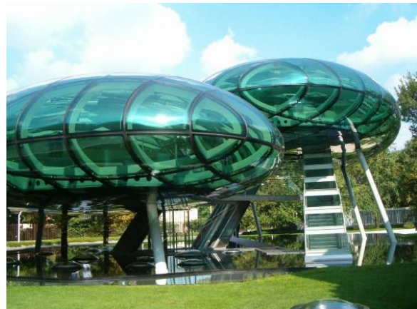
Img. 2: Unique double curved glass panes; architetturaeviaggi.it (2011)
