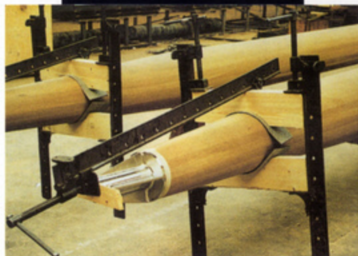
[Het glazen dak van het atrium van Portcullis House bevat een gelamineerde eikenhouten constructie en geldt als het meest complexe houten bouwwerk dat ooit in Engeland is uitgevoerd.]
