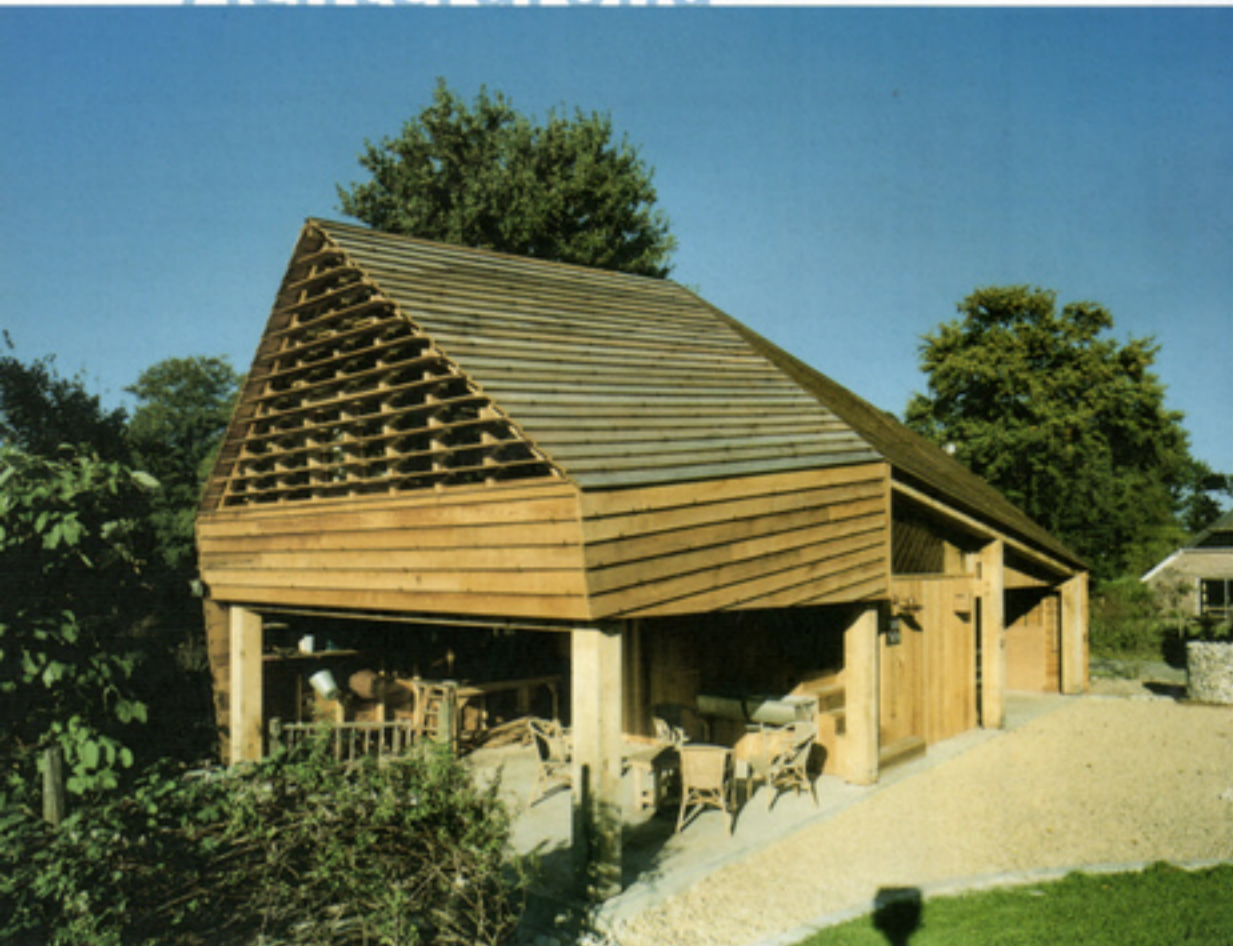
[De complete draagconstructie van de 'multifunctionele schuur Noord-Laren' is opgebouwd uit eiken.]
